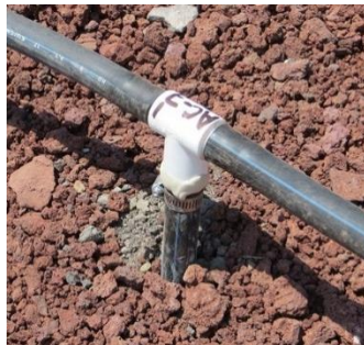
Conexión de dren vertical y tubería horizontal
